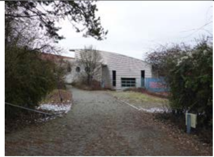
Abb. 7: Versiegelte Zufahrt zum UG mit Parkplätzen
