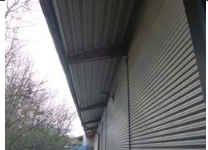
Abb. 13: Strukturarme Blechfassade im Osten
