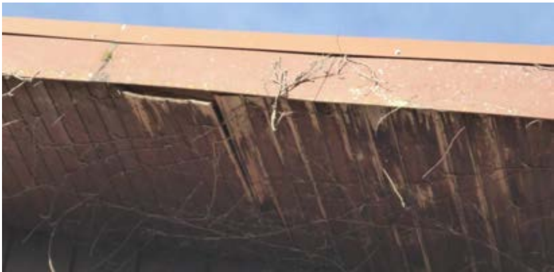
Abb. 4 Spaltenöffnungen aufgrund von Alterungserscheinungen der Dachverkleidung
