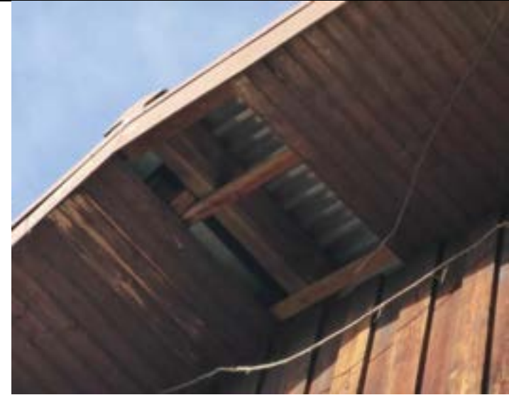
Abb. 11: Beschädigungen an der Dachverkleidung
